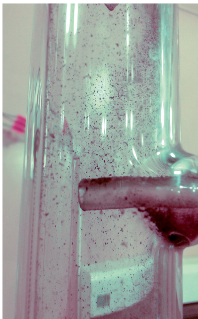
Fot. 5. Zabrudzona czerpnia
