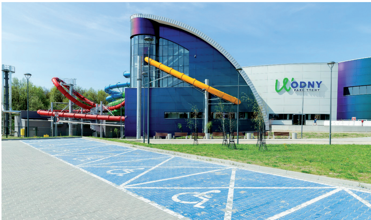
Fot. 2. Bioelektrociepłownia zasilana biogazem w Wodnym Parku Tychy
