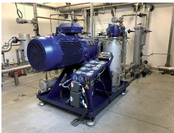
Fot. 1. Instalacja technologiczna – stacja oczyszczania biogazu (SOB)
