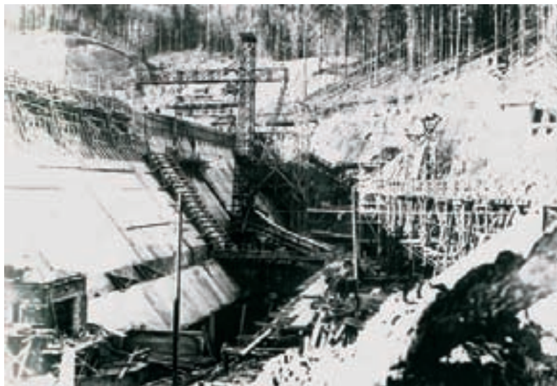
Fot. 1. Budowa zapory w Wapienicy. Fotografia archiwalna z ok. 1930 r. Własność AQUA S.A.
