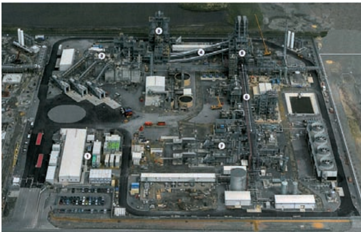
Fot. 1. Widok wysokotemperaturowej instalacji zgazowania odpadów z palnikami plazmowymi.
