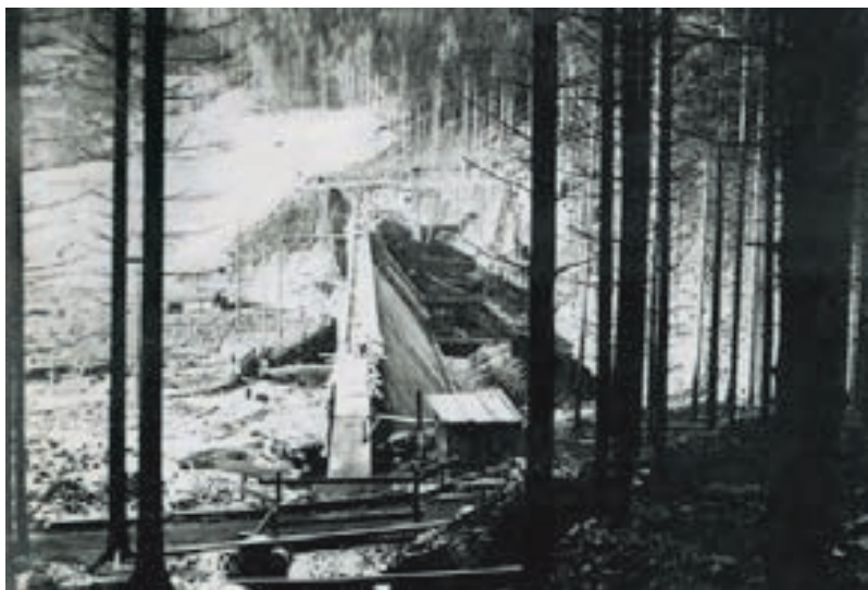
Fot. 2. Budowa zapory w Wapienicy. Fotografia archiwalna z ok. 1930 r. Własność AQUA S.A.
