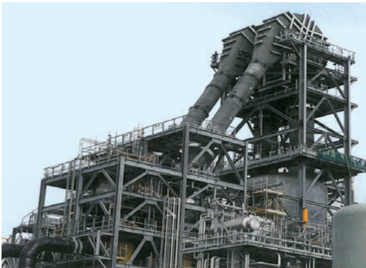
Fot. 2. Widok reaktorów szybowych z systemem podawania i załadunku masy wsadowej (fot. Westinghouse Plasma Gasifier at the Valley #1 Site in Tees Valley, UK).
