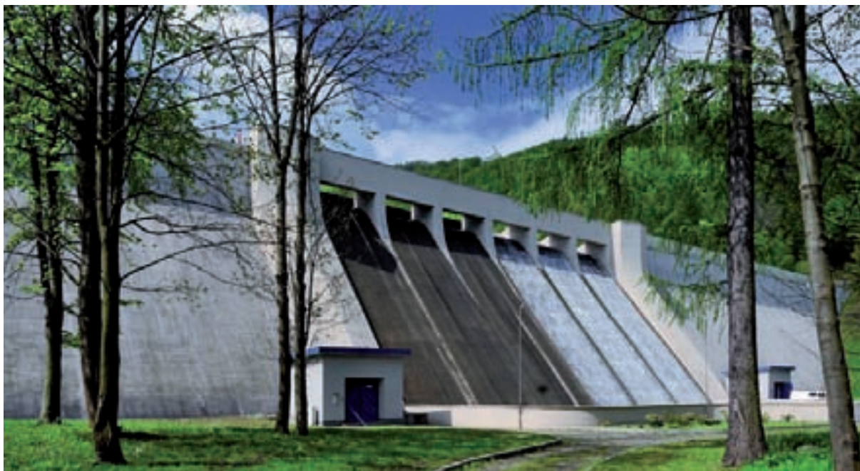
Fot. 4. Zapora w Wapienicy (po remoncie strony odpowietrznej). Fot. L. Cykarski. Własność: Aqua S.A.
