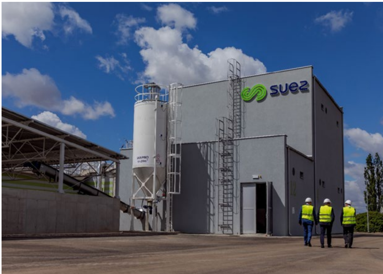
Oczyszczalnia ścieków w Mławie / @SUEZ Woda
