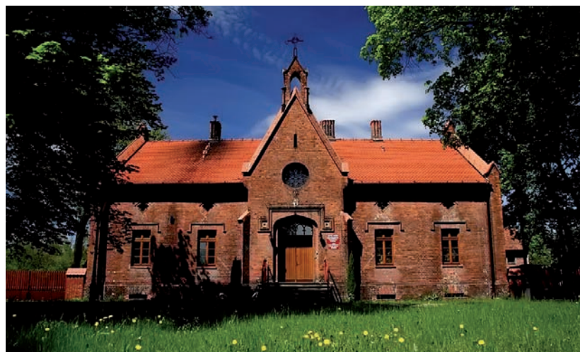
Budynek siedziby Oddziału ZPKWS w Rudach
