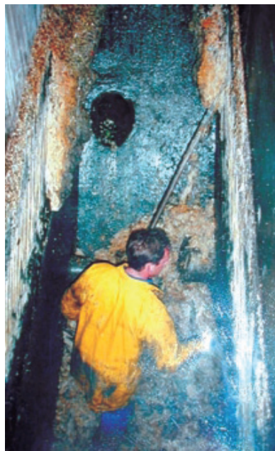
Fot. 5. Usuwanie osadu w kanałach kanalizacyjnych, źródło [8].
