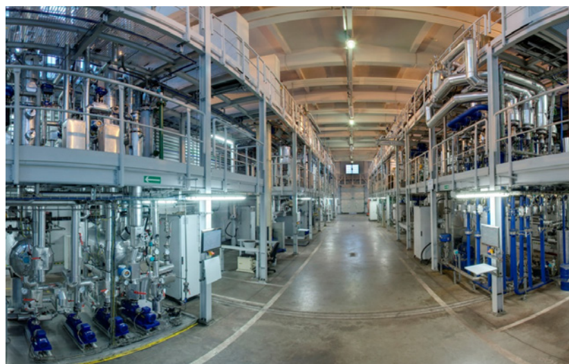
Hala technologiczna Centrum Czystych Technologii Węglowych ITPE.
