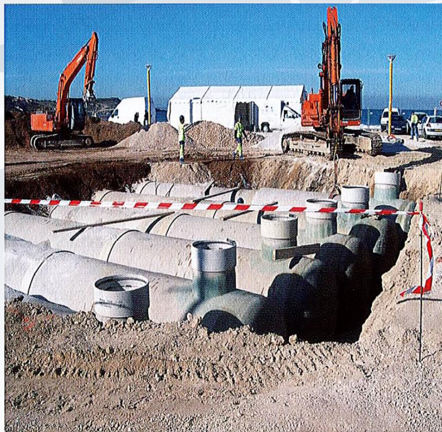
fot. 10 Zbiorniki retencyjne w układzie równoległym montowane na bazie rur Flowtite
