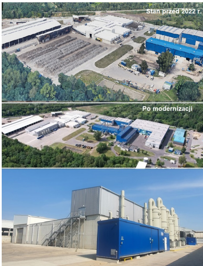
Fot. 1. Zakład przed i po modernizacji
