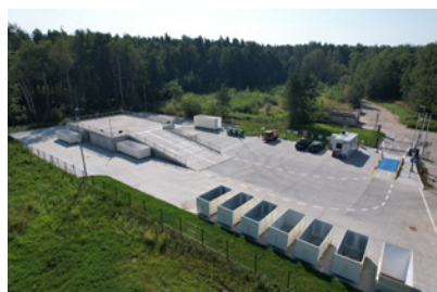
Fot. 2. Zmodernizowany GPZO przy ul. Zaopusta (autor: KAW)
