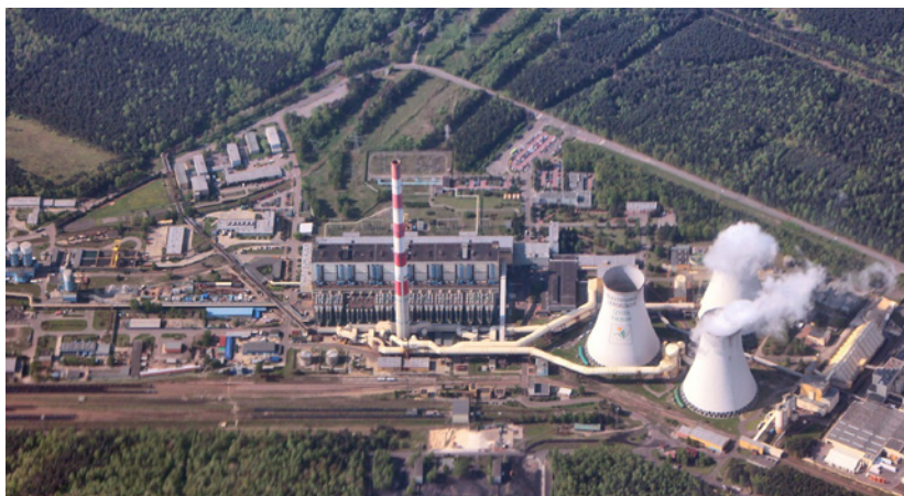
Elektrownia Jaworzno III – 2013 rok
