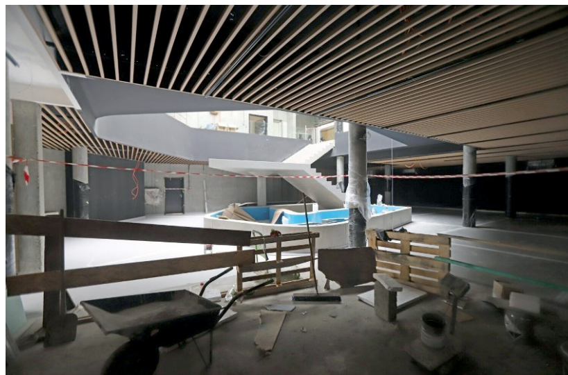
Prace budowlane w nowym obiekcie są na ukończeniu (fot. UM Sosnowiec)
