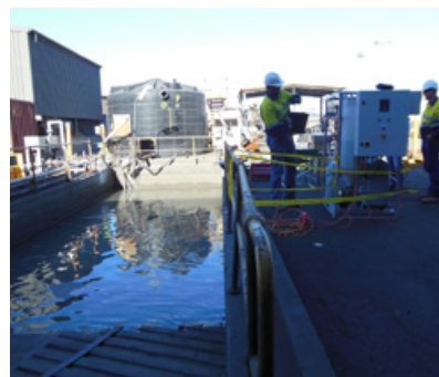
Fot. 3. Stacja mycia sprzętu
