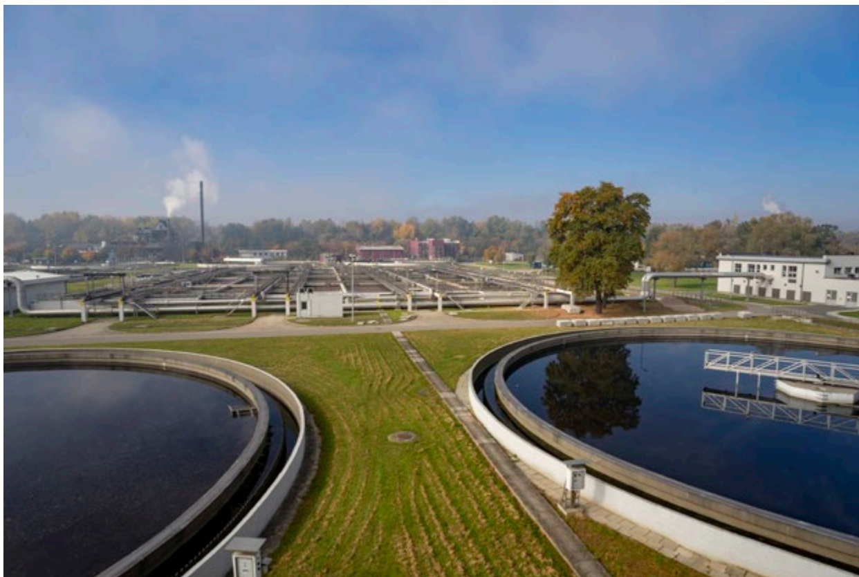
Zakład Oczyszczania Ścieków Kujawy – osadniki wtórne
