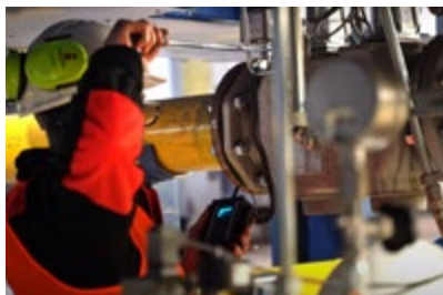
Fot. 2. W trakcie rozruchu kotła gazowego dostrajano i regulowano poszczególne jego elementy i zasilających go palników. Fot. MEC Koszalin
